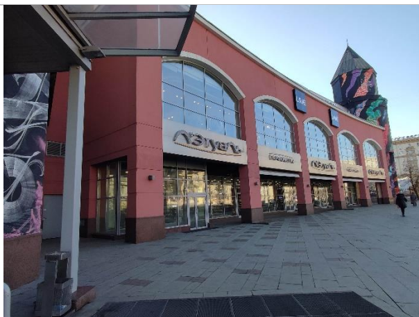
Фотография 3.2. Внешний вид здания
