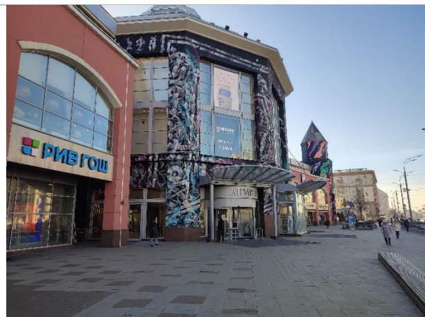
Фотография 3.1. Внешний вид здания
